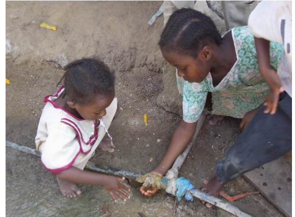
Molteplici perdite lungo la rete idrica disastata
